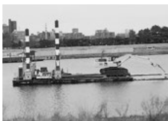
多摩川の浚渫(しゅんせつ)工事
